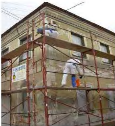
entfernen der alten Farbe
