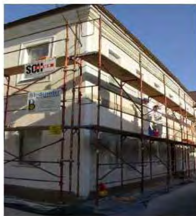
neu verputzen mit Universalputz
