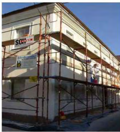
neu verputzen mit Universalputz
