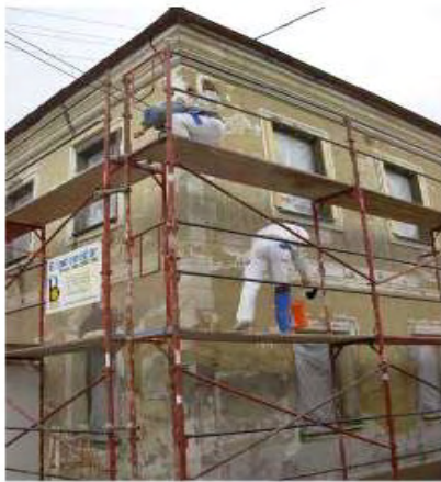
entfernen der alten Farbe
