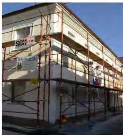
neu verputzen mit Universalputz
