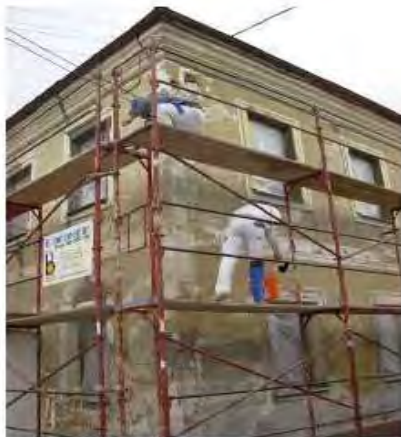
entfernen der alten Farbe
