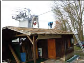
Die Lattung ist fertig.
